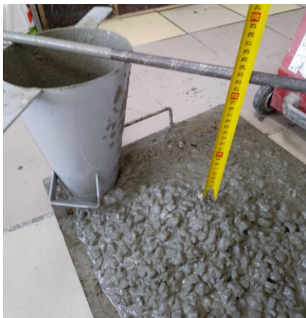
Рис. 7 Визначення рухомості бетонної суміші
